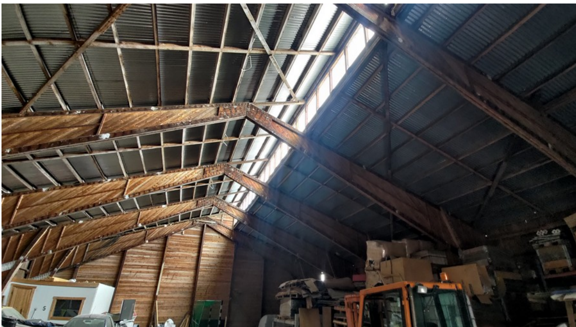
Kuva 4. Keskimmäisen makasiinin pohjoisosa, jossa on kattoikkuna.
