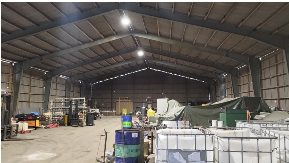
Kuva 5. Pohjoisin makasiini sisältä.
