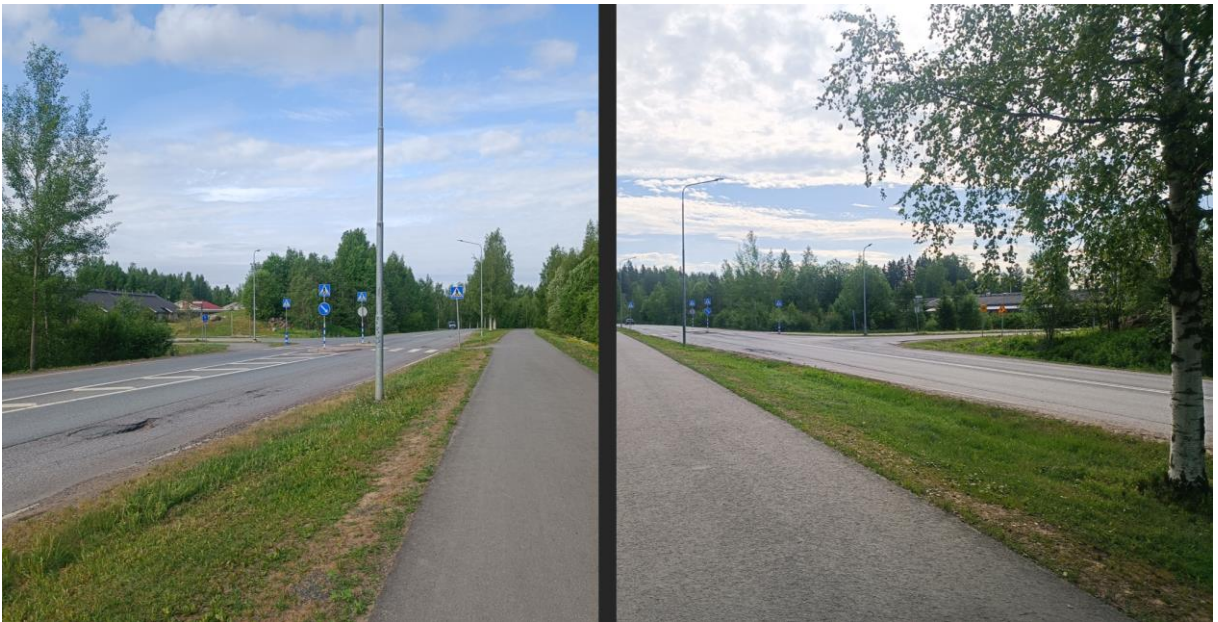
Kuva 6. Taipaleentien liittymäalue. Vasemmalla näkymä länteen pitkin Uusi Karhintietä. Oikealla näkymä itään.
