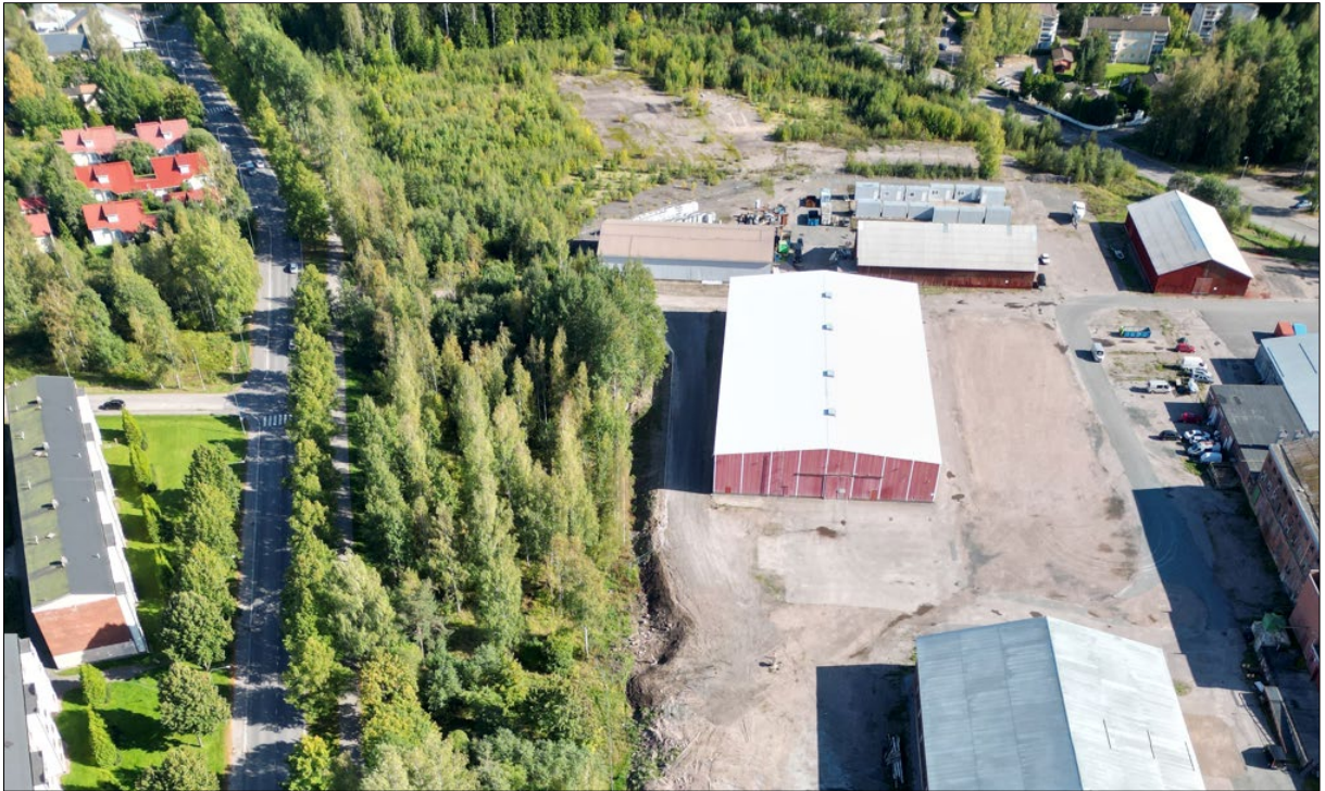
Kuva 3. Suunnittelualan rakennukset ja lähiympäristöä lännestä päin kuvattuna. Kuvan vasemmassa reunassa Lasitehtaantie. (Riihimäen kaupunki, 2023)
