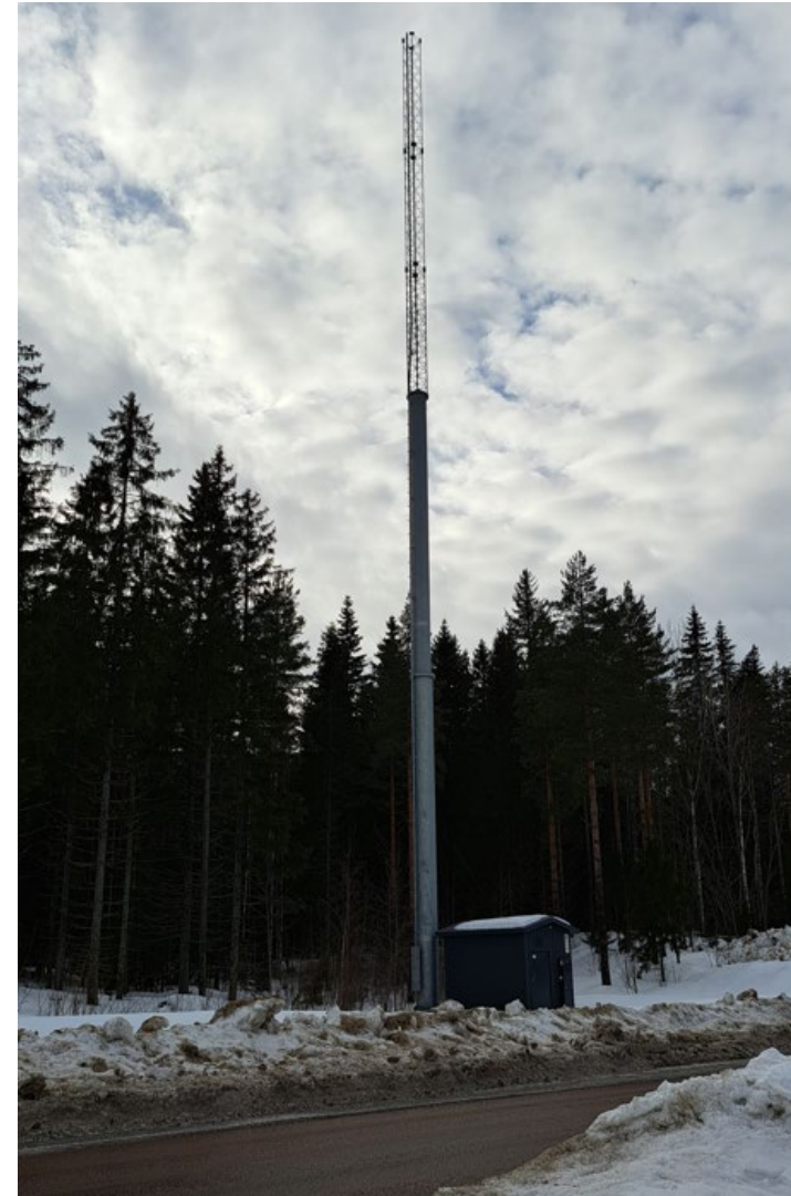
Kuva putkimastosta ja laitetilasta
