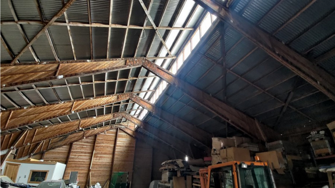
Kuva 4. Keskimmäisen makasiinin pohjoisosa, jossa on kattoikkuna.
