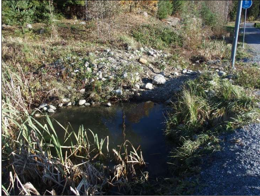
Kuva 8. Esimerkki jalankulku- ja pyöräilyväylän reunaojasta, johon on toteutettu pieni allasmainen levitys ja pohjapato. Kiintoaineksen poistamista työmaavesistä voidaan edistää vastaavalla rakenteella. Pohjapadon materiaalina tulisi käyttää esimerkiksi salaajasoraa ja louhetta. © Destia Oy 2024.
