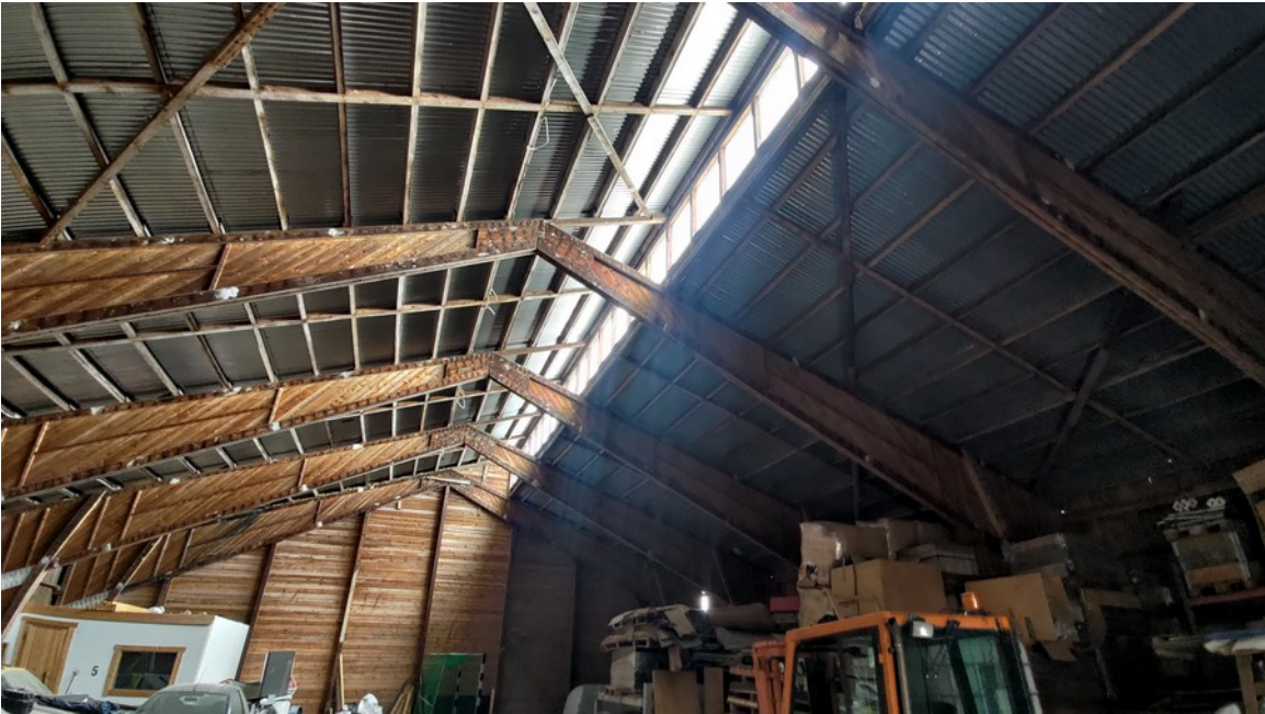
Kuva 4. Keskimmäisen makasiinin pohjoisosa, jossa on kattoikkuna.
