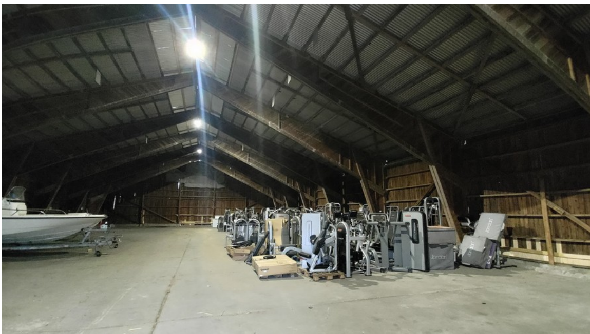
Kuva 2. Eteläisin makasiini (numero 6) kuvattuna sisältä.
