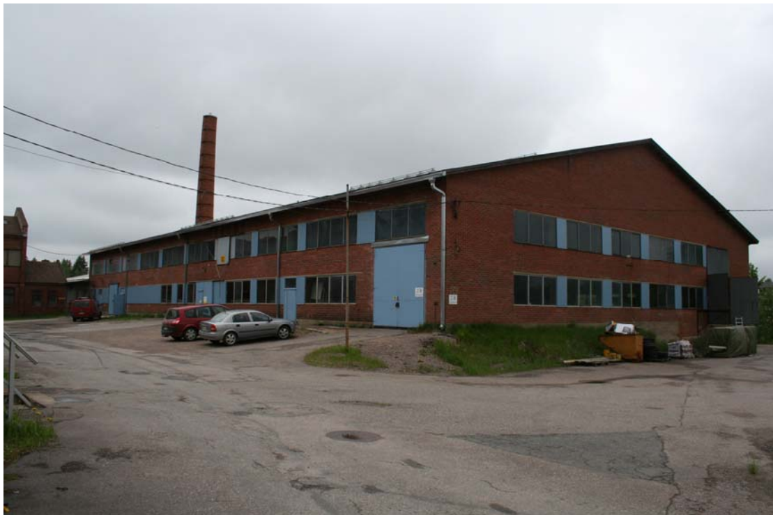
4a-b Varasto ja rakennuslasitehdas eli Talous- ja taidelasitehdas. Kuvassa näkyy myös luhistumassa oleva savupiippu.
