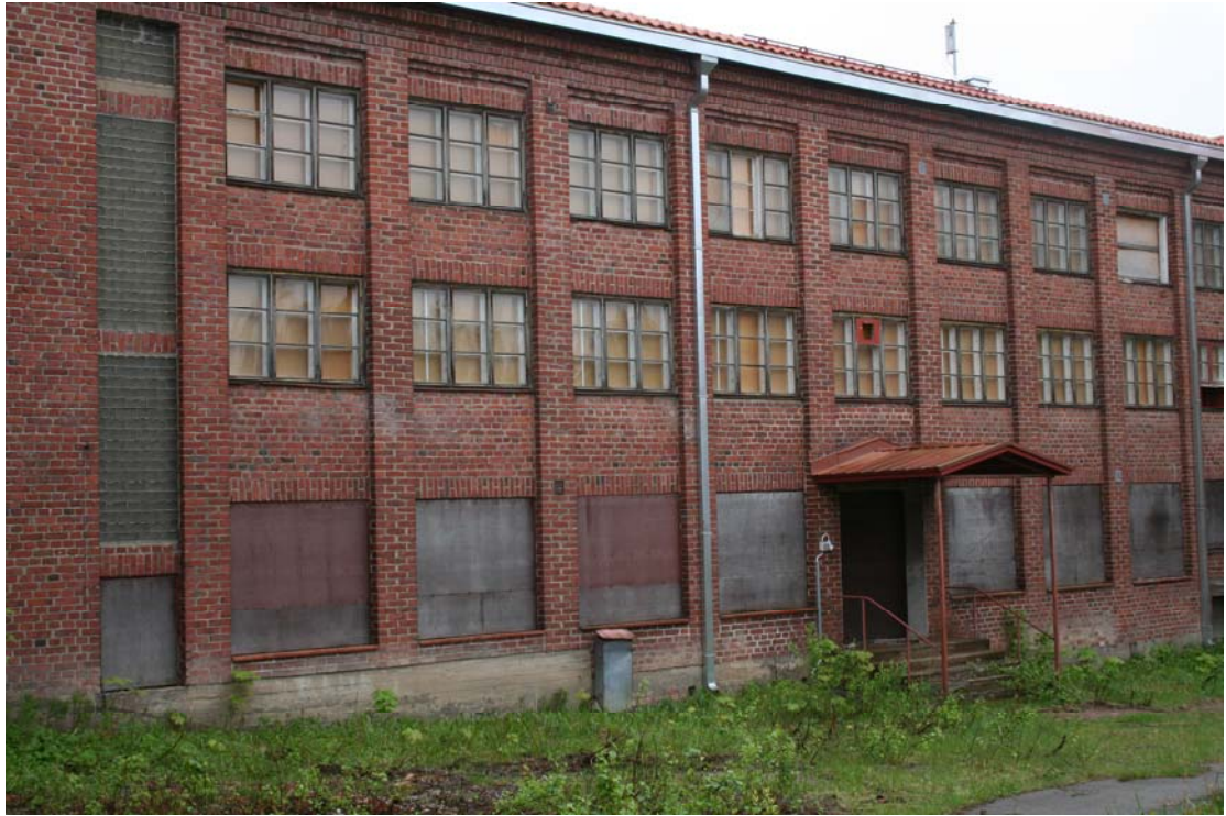
Konttorirakennus / tehdasrakennus sisäpihan puolelta.
