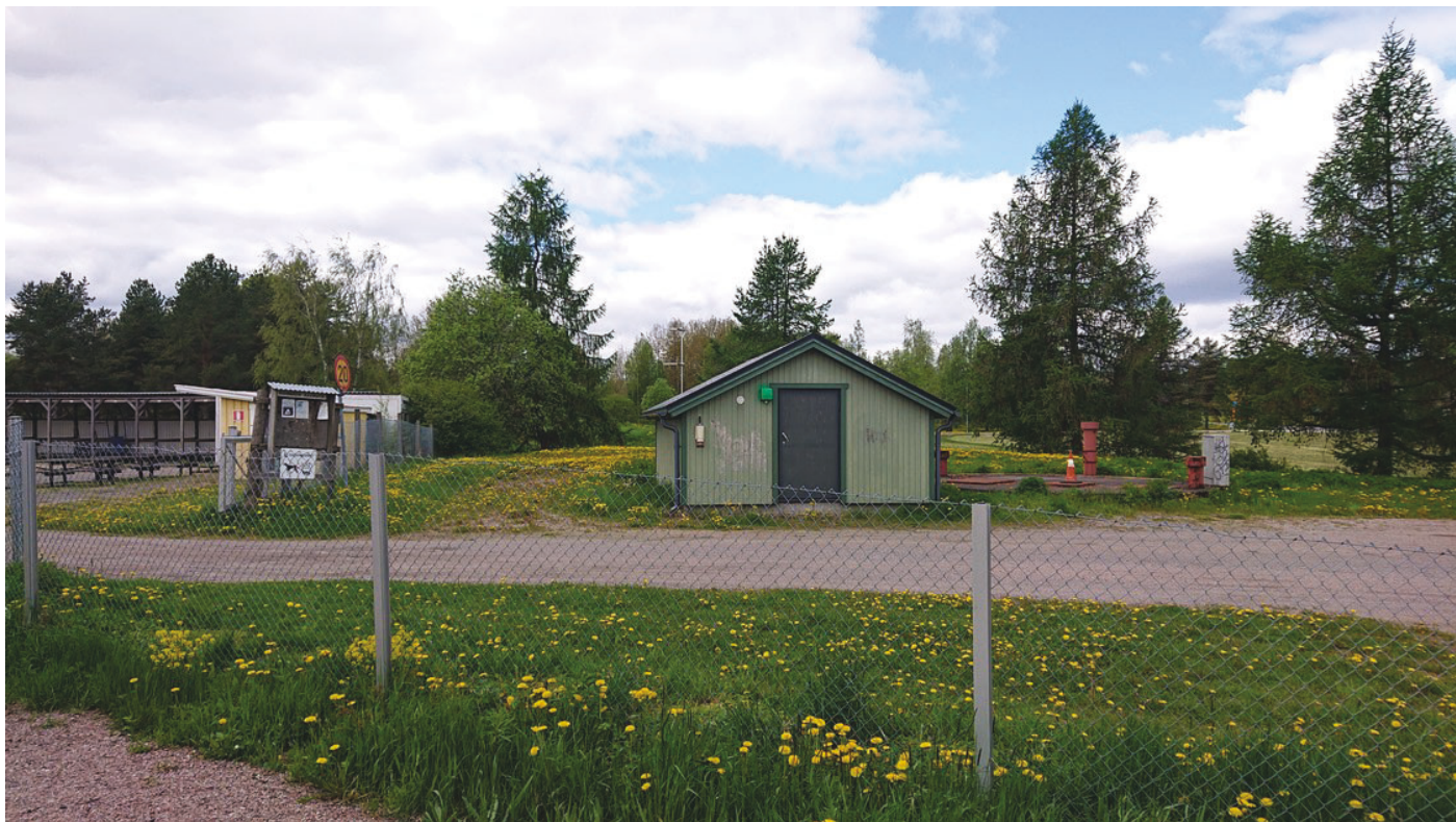
Liitekuva rakennuksesta 14. Pumppukoppi.
